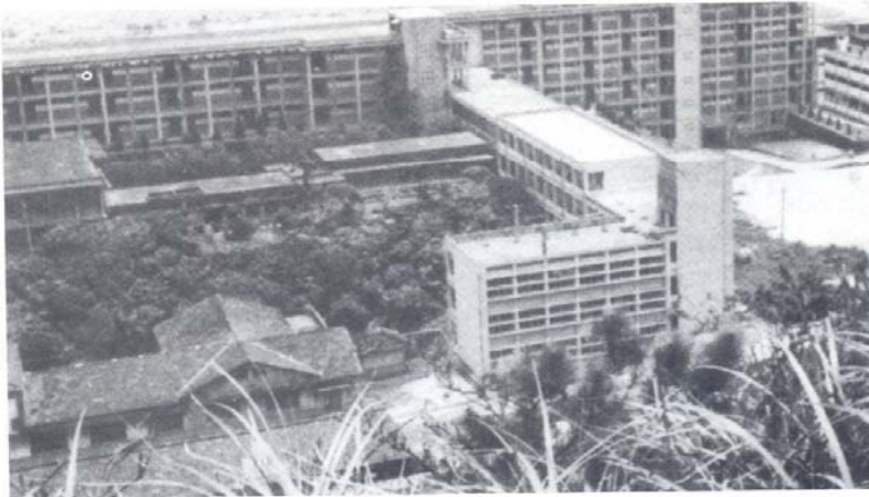
6. 民國五十七年海事大樓乙幢完工。
